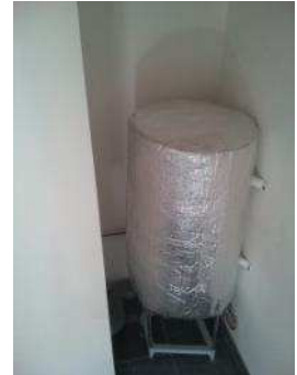
Exemple de ballon équipé d'une housse isolante
